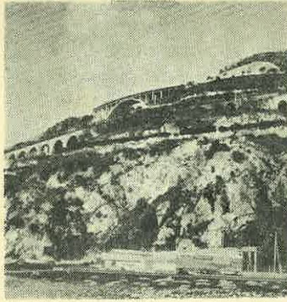
Şekil 5. Tren yolu, yeni kara yolu ve eski kıyı yolu peyzajla kaynaşmış durumda.
